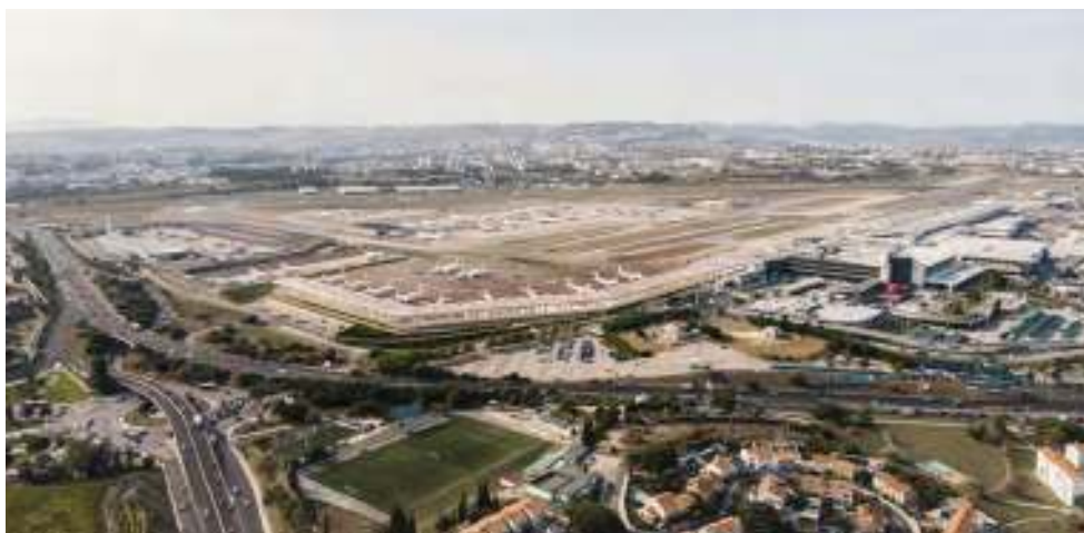
Obra de ampliação do Pier Sul do Aeroporto de Lisboa (©Engexpor)
